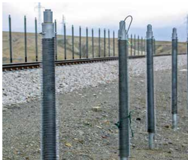
▲ Afb. 11. Thermosyphons (thermistors) langs een spoorlijn. Foto: J. Vandenberghe.
