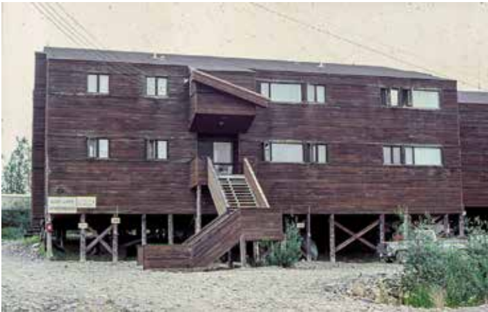
▲ Afb. 8. Appartementengebouw op palen om in de winter koude lucht over de bodem te laten ventileren en zo de permafrost bevroren te houden. Foto: J. Vandenberghe.
