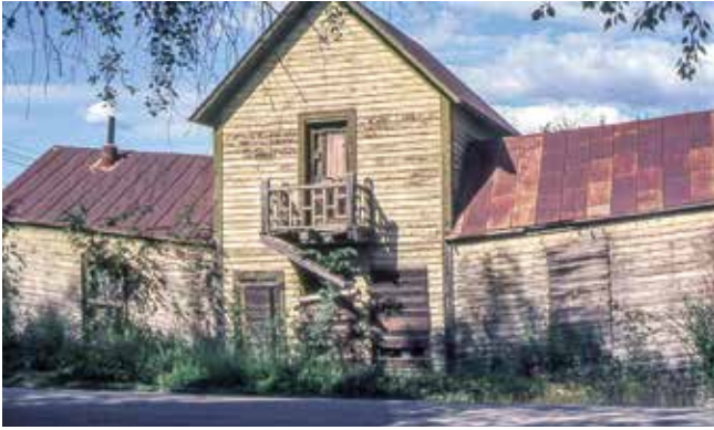
▲ Afb. 7. Oud houten huis; het middendeel is verzakt door ontdooien van permafrost. Foto: J. Vandenberghe.
