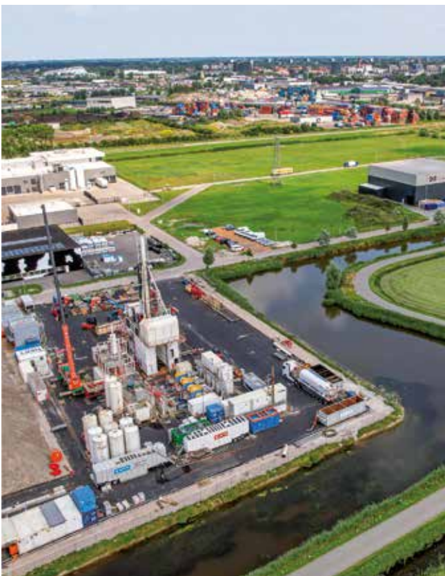
▲ Afb. 4. Dronebeelden van de boorinstallatie in Leeuwarden, waar naar aardwarmte geboord wordt. Bron: EBN.
