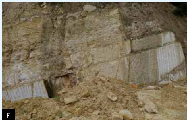
▲ Afb. D, E en F. Gebruik van cement dat in de loop van de tijd uitzet waardoor grote steenbrokken loskomen van de zandsteenbank.
