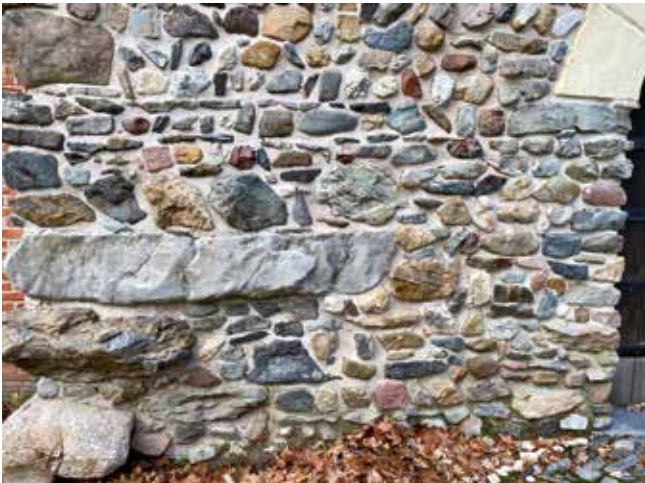
▲ Afb. 17. Leuk voorbeeld van het gebruik van onbewerkte Maaskeien (Pleistocene Maasgrinden of "zuidelijke zwerfstenen") in het 11e-eeuwse schip van het kerkje van Erpekom, nu opgesteld in het Openluchtmuseum van Bokrijk, Genk. Let op de enorme lithologische variatie (diverse soorten van Cambrium kwartsieten, Devoon-conglomeraten, Paleozoïsch aderkwarts, Devoon zandstenen, ...).
