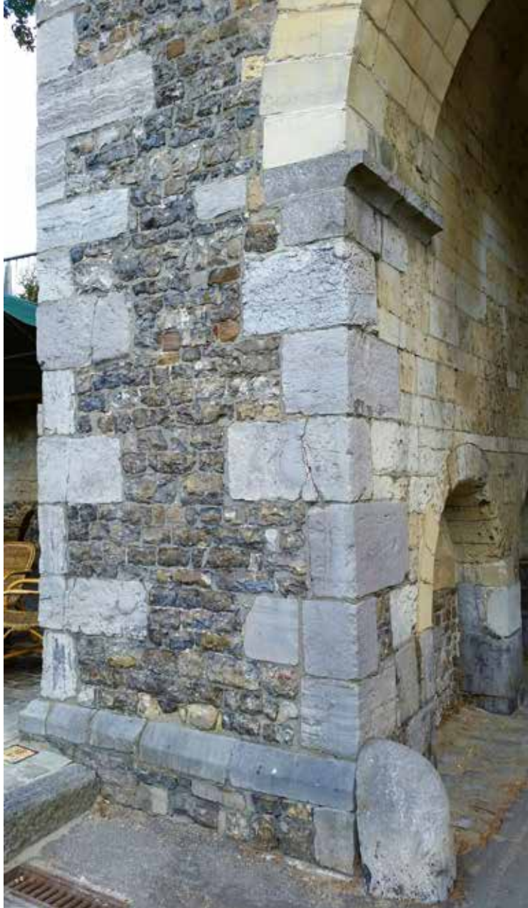
▲ Afb. 10. Verschillende asgrijs gepatineerde blokken Maaskalksteen (Onder-Carboon) en koraalrijke Devoonkalksteen (Frasniaan, Boven-Devoon) naast kleinere blokjes grijze vuursteen en strogele Maastrichtersteen ("mergel") uit het Maastrichtiaan in de Middeleeuwse Moerepoort (1379) van Tongeren.
