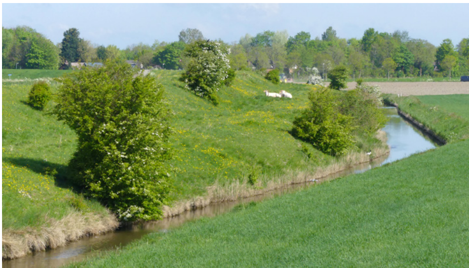
1. Structuurrijke dijk met meidoorns en runderbeweiding. Bruinisse, april 2022. Foto: Niels Godijn
