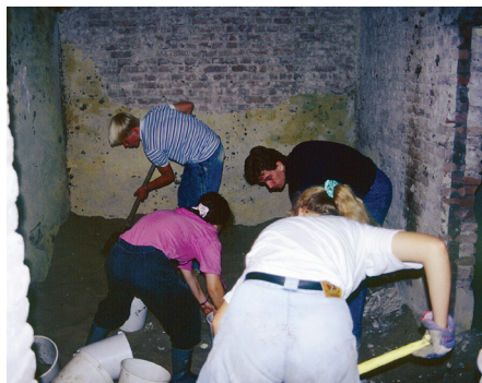
Leegscheppen van de bunker. Foto: Jan Alewijn Dijkhuizen
