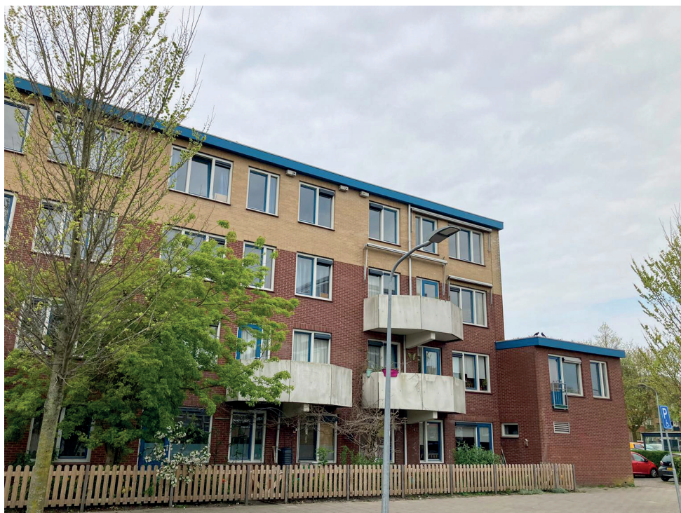
DRIE KASTEN hangen nu aan de oostgevel aan de Frankrijklaan, 1 mei 2023. Foto: Peter Spolders
