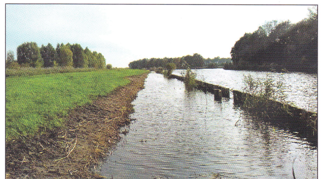
Figuur 3. Dezelfde oever van het Stoppelsoal met weggegraven habitat rietmoerasvegetatie. De enkele overgebleven planten zijn verstrengeld in de oude, verwaarloosde palenbeschoeiing. Het nieuwe palenscherp heeft hier één van de weinige openingen. Lokaal ligt onder water nog het “beschadigde” kunststofdoek van de vorige inrichting, 20 oktober 2021 (foto zie figuur 1).
