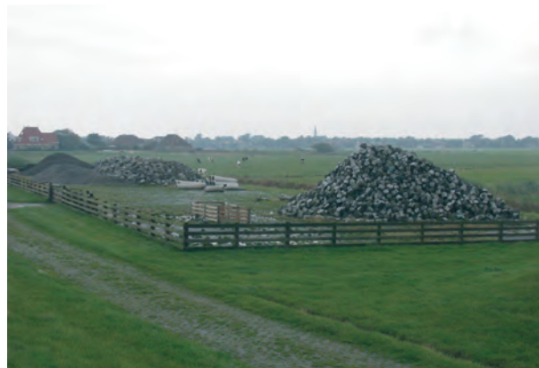
Fig. 1: De opslagplaats van stenen voor versterking van de Waddenzeedijk ten oosten van Stryp/Seerijp, gezien vanaf de dijk - herfst 2012. Foto: Henk Mienis.
