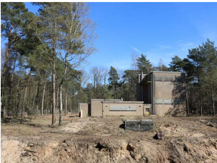
FIGUUR 3 Achterzijde van het voormalig pompstation Herkenbosch. Van links naar rechts de machinekamer, het (verdiepte) pompgebouw, de tussenbouw en de spoeltoren. Op de voorgrond de met zand bedekte kleine reinwaterkelder (foto: Ton Lenders).
