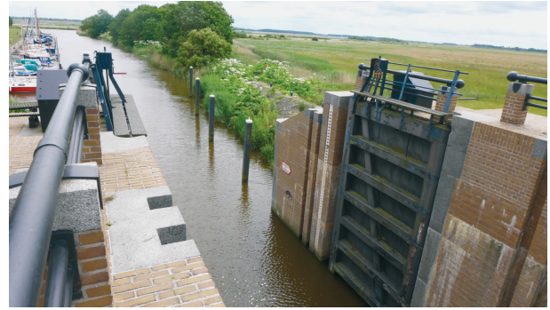
Fig. 5. Sluis bij Ezumazijl (bij locatie2) (foto Frank de Graaf)
