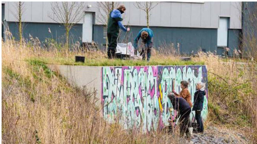
Hooligans? Nee, Herstelwerkzaamheden aan de oeverwaluwand bij Duivendrecht op 15 maart
