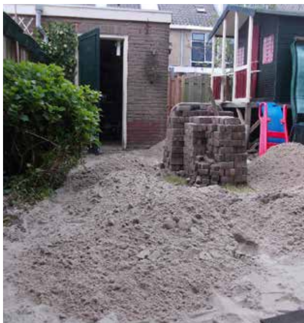
Fig. 1. Met zeezand opgehoogde tuin in Bodegraven. Foto Corine van de Woestijne.
