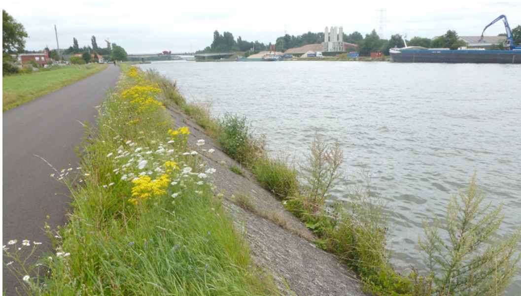
Figuur 7. Het Albertkanaal te Massenhoven, 8 augustus 2012 (Foto: Geert De Knijf). The Albert Canal at Massenhoven (Belgium), 8 August 2012.
