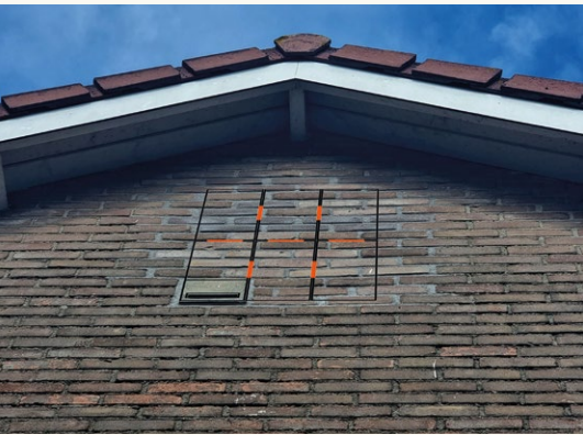
▲ Figuur 2. De inbouwkasten werden in een cluster van zes geschakelde kasten in blinde muren ingebouwd. Na het inbouwen is alleen nog de entree zichtbaar als een brievenbus (op een vreemde plaats). Foto Wiegert Steen
