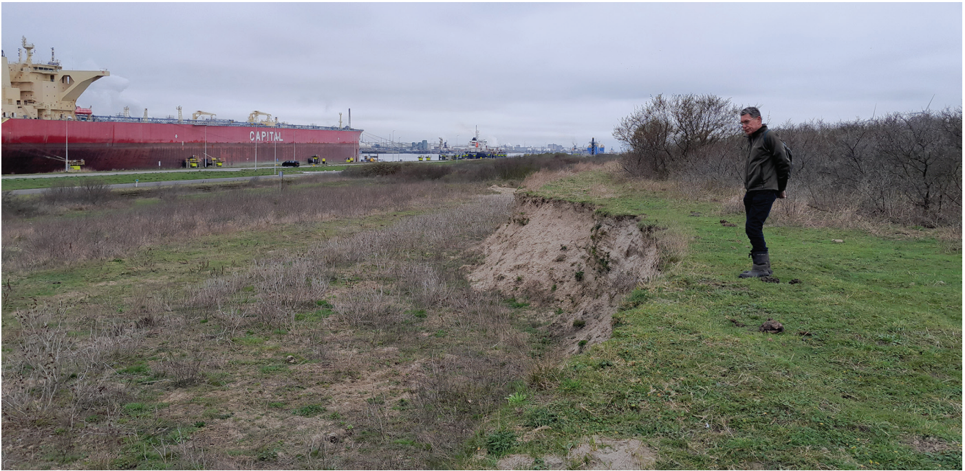
Wim op de oeverwaluwand. Foto: Jan Alewijn Dijkhuizen.
