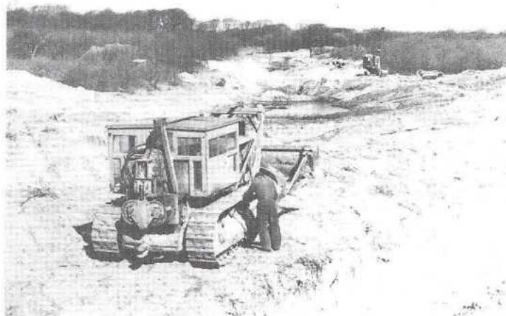
Aanleg Verlengde Oosterkanaal 1956
