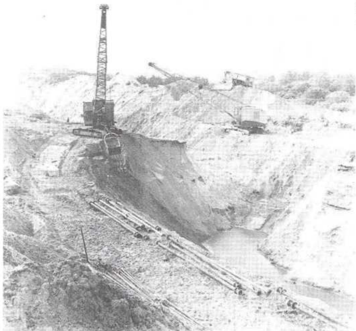
Aanleg draineerleiding in het infiltratiegebied 1955
