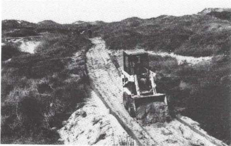
Aanleg van 2 m brede paden naar het strand
