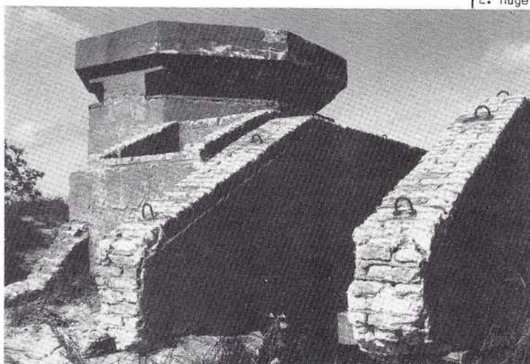
Soms kunnen bunkers geschikt worden gemaakt voor vleermuizen
