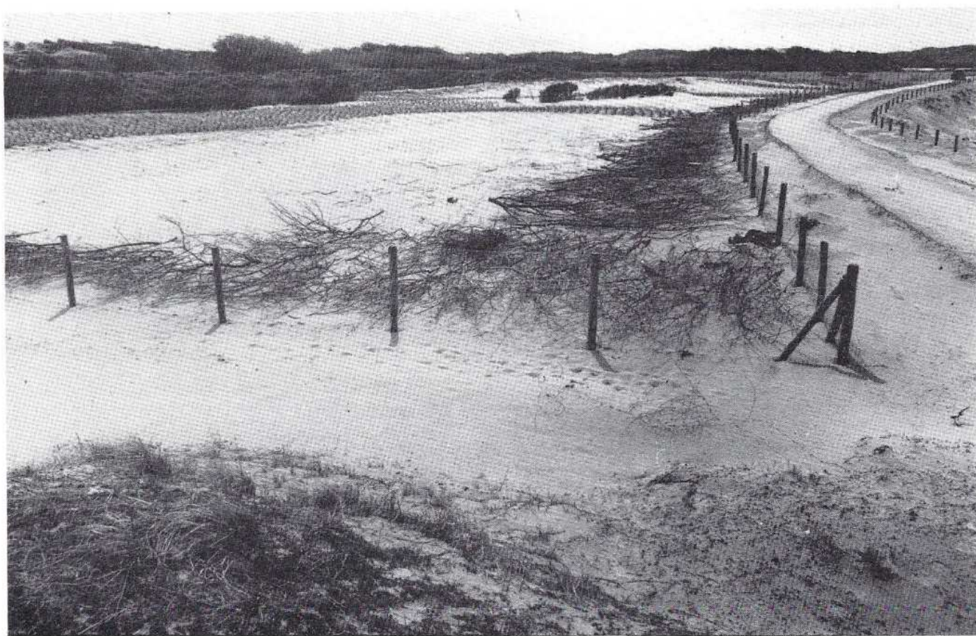
Dezelfde plek in mei 1987 na voltooiing van de werkzaamheden (foto E. Hüge).
