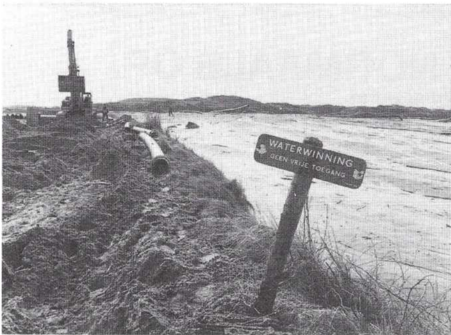
Zandopspuiting bij de Duitse Muur in Berkheide ten behoeve van de aanleg van een nieuw winningsmiddel (foto: E. Hüge).
