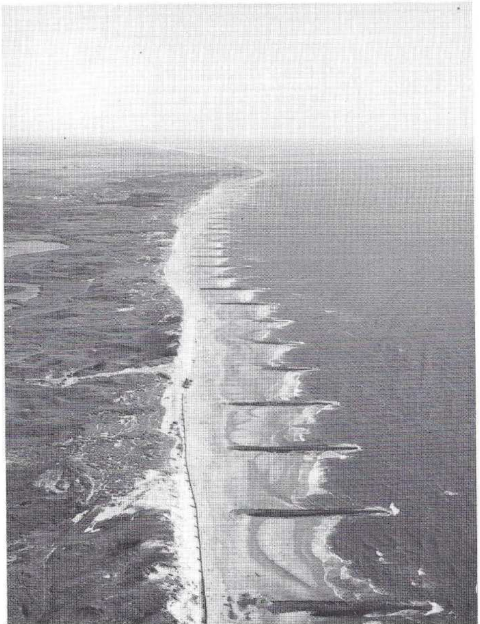
Luchtfoto ter hoogte van het Zwanewater (voor de recente suppletie), in zuidelijke richting. Op de achtergrond, ver in zee uitstekend, de Hondsbossche Zeewering (foto: Aerophoto Schiphol).
