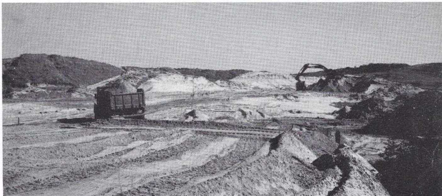
Werk in uitvoering voor het nieuwe 'tijdelijke' (?) racecircuit in de Zandvoortse duinen (foto: C. van Schaik).
