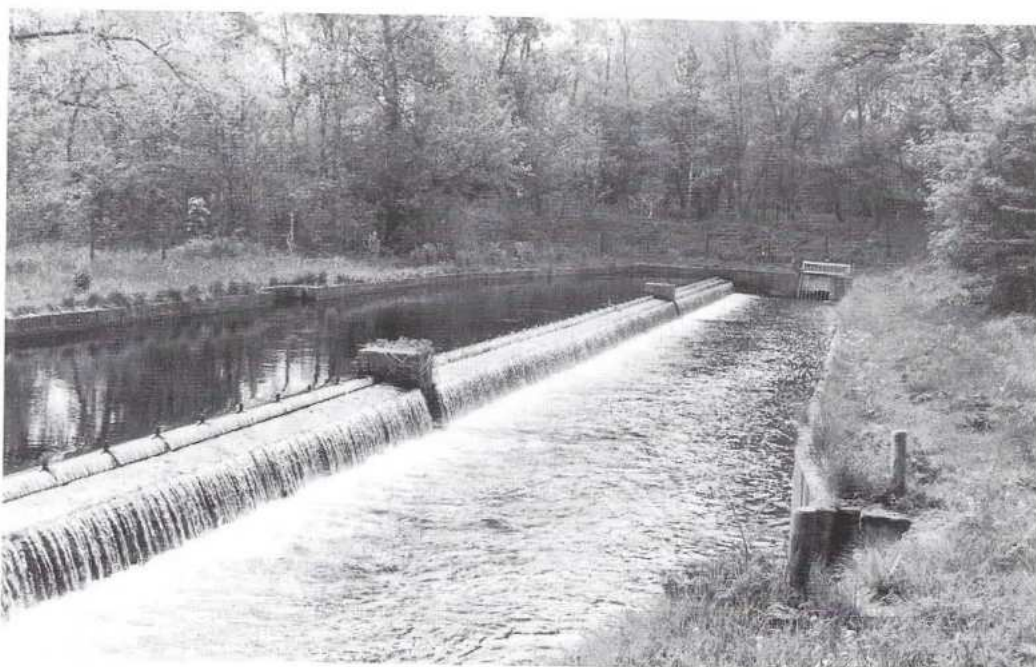
Het voorgezuiverde rivierwater wordt over een kunstmatig watervalletje het duin in gevoerd (foto: Marc Janssen).
