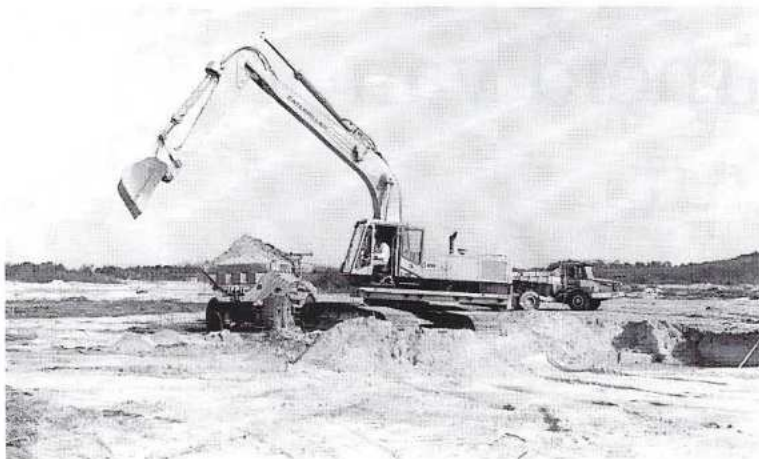
De graafwerkzaamheden in 1991 (foto: Frans Nieuwenhuizen).
