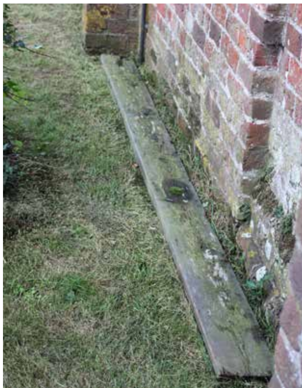
Fig. 2. De plank langs de noordmuur van de kerk. Foto Henk Mienis.
