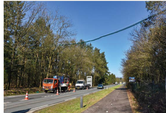
▲ De aanleg van een 'ladderbrug' in Otterlo. Foto Frans van Bommel
