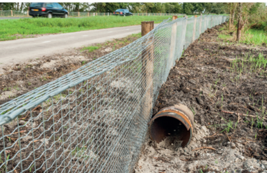
▲ Otterpassage onder Veneweg. Foto Roel Hoeve
