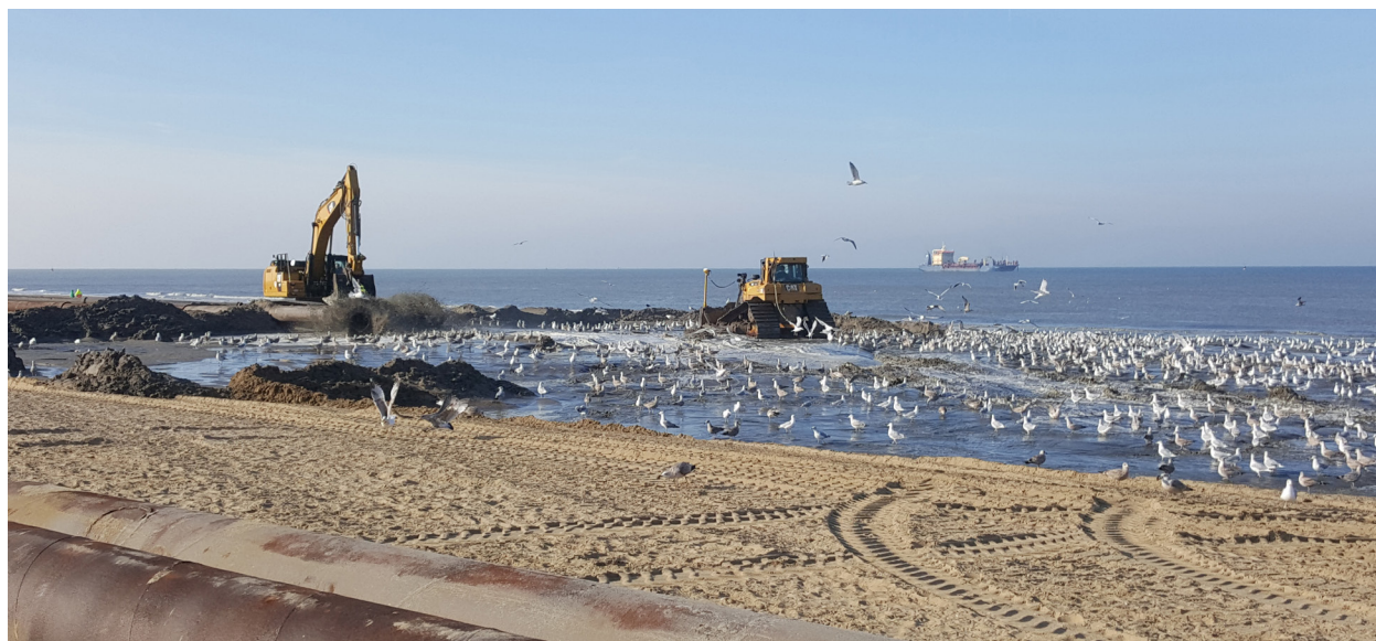
Fig. 3. Overzicht van de opspuiting van 2019: het zuigschip (in lospositie), de pijpleiding, de spuitmond (onder de dragline); dragline en bulldozer die het opgespoten zand egaliseren en talloze hongerige meeuwen.
