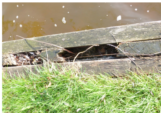
Figuur 3. Aantasting van de beschoeiing, veroorzaakt door F. lilacinogilva . (Foto: T. Laarman)
