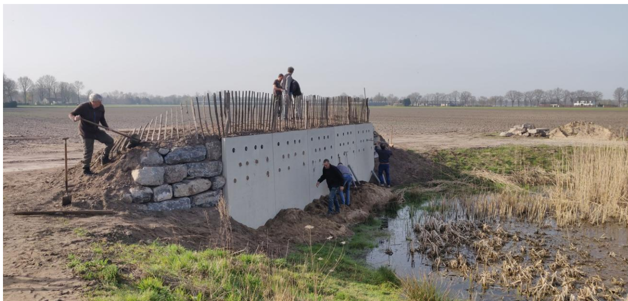
Aanleg van de Oeverwaluwwand, 1 april 2021 (JA).
