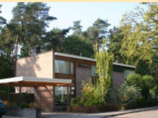
De huizen aan de Zandstraat hebben een plat dak en open stootvoegen bij de blinde muren.
