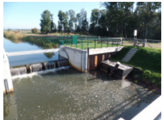
Vissluis tussen brug en stuw.
