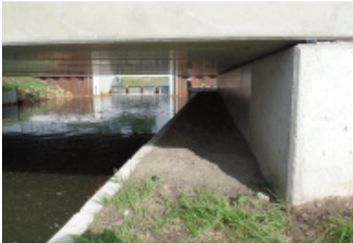
Otterpassage - doorlopende oever onder vernieuwde brug.
