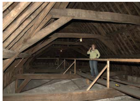
▲ Kerkzoldertelling. Foto Kamiel Spoelstra
