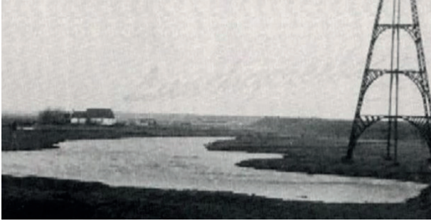
Fig. 2. De restanten van de oesterhaven van Oosterend voor de dijkverhoging van 1979. Rechts de IJzeren Kaap. Bron: http://www.texel-plaza.nl/nieuws/artikel/030630/2007-12-15/
