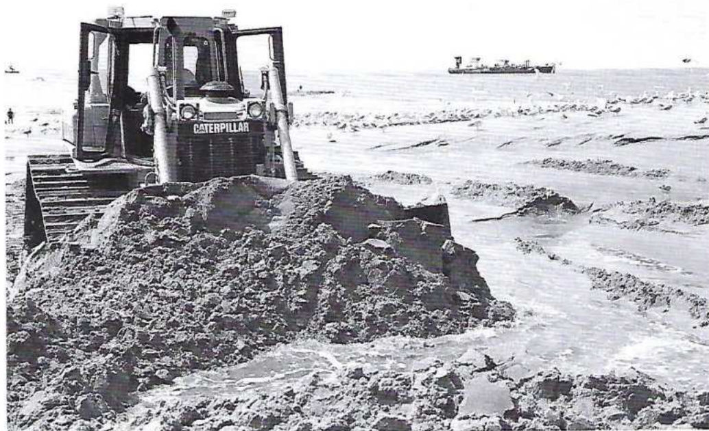
Zandsuppleties zijn een structurele maatregel geworden om de kustlijn van Texel te behouden (foto: Marc Janssen).
