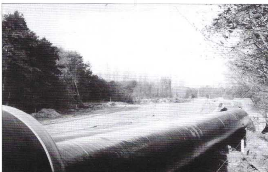
Watertransportbuizen met een diameter tot 1000 mm. lopen dwars door een kaalgeslagen binnenduinstrand bij Beverwijk (foto: Henk van Bourgonje).
