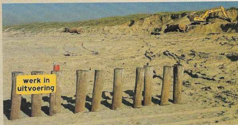
De realisatie van een gat in de zeereep bij Schoorl (de "Kerf") betekende een radicale omslag in het denken over kustbeheer (foto: Henk Wijkhuisen).
