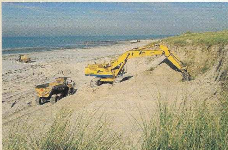
Het graven van De Kerf, begin november 1997 (foto: Henk Wijkhuisen).
