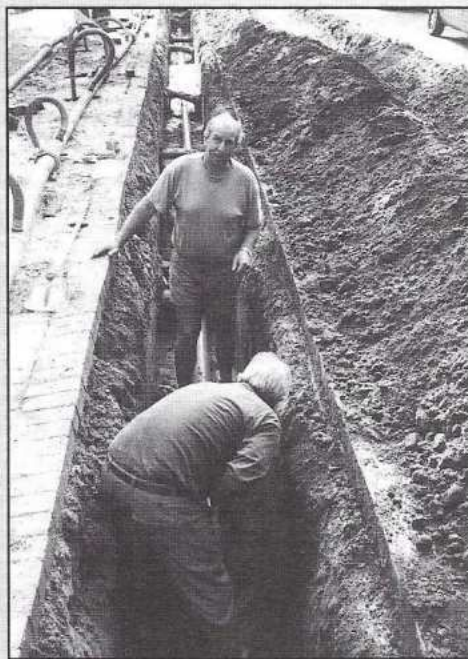
Aanleg van een drainagesysteem in Bloemendaal. (foto: P. Donckerwolckel/Fa. Vermeer)
