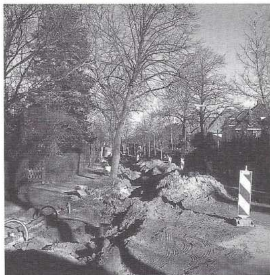
Een riool wordt vervangen in Aerdenhout. Dit is een goede gelegenheid om tevens drainagesystemen te realiseren om wateroverlast tegen te gaan (foto: NV PWN/Chris van Deursen).
