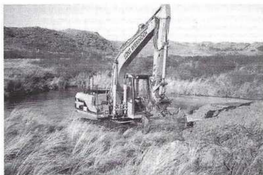
Het ophogen van een ondergelopen teellandje voor aardappelen langs het Duinpieperpad nabij Zandvoort (foto: NV PWN/Dirk Vink).
