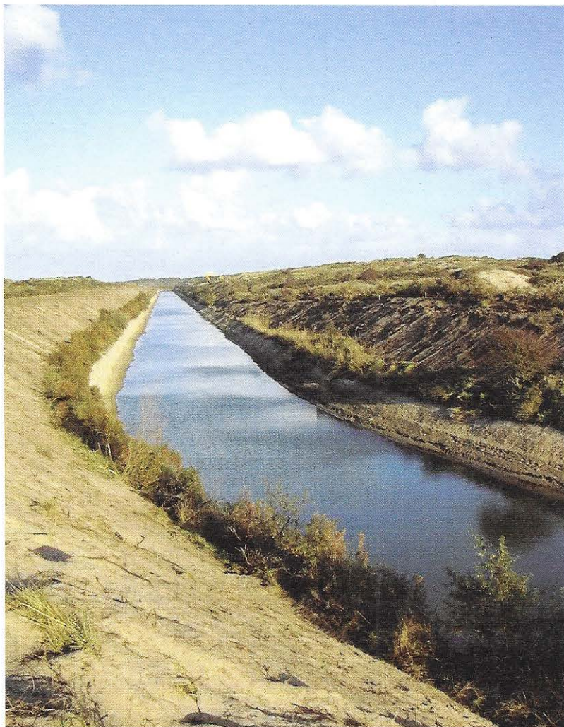
Voor het dempen van het Van Limburg Stirumkanaal zijn eerst de oevers opgeschoond (foto: Joop Hilster).
