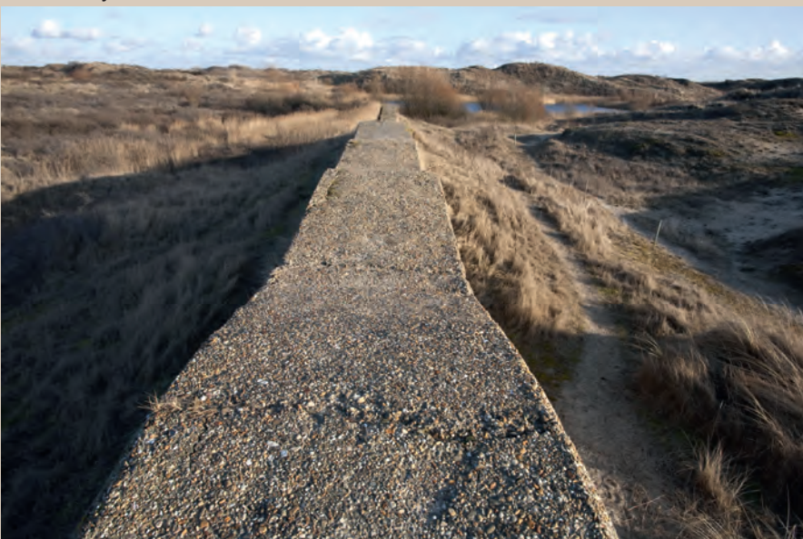
Lange linten van beton doorsnijden het duingebied Berkheide ten zuiden van Katwijk. Foto: Joost Bouwmeester.
