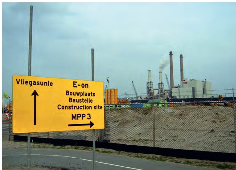
Locatie van de E.ON centrale in aanbouw naast de huidige centrale op de Maasvlakte. Foto: Dick van der Laan.
