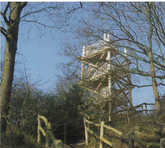
Dit nieuwe uitkijkpunt is niet nieuw: de toren is gebouwd op de plek waar zich voorheen de fundering van een brandwachtershuisje bevond. Foto: Jan van Mourik.
