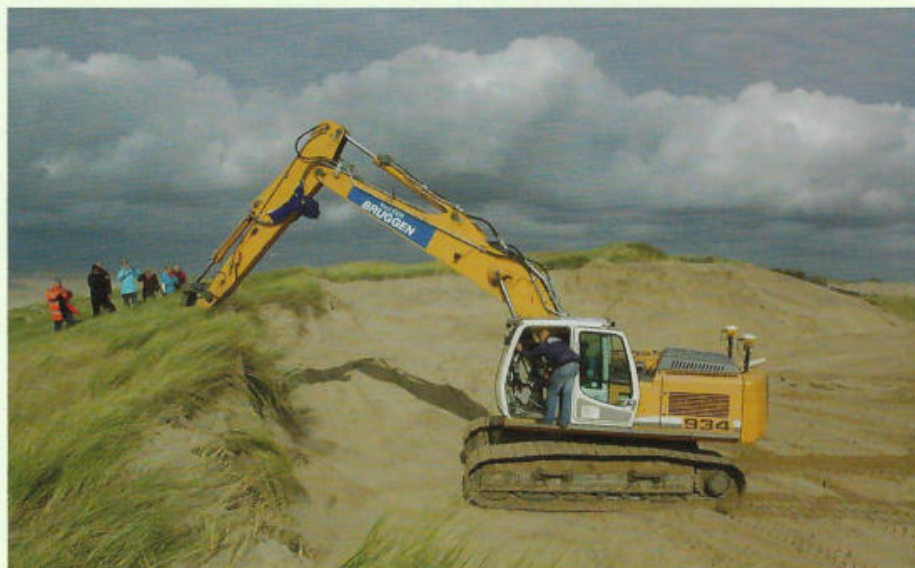
Een grote graafmachine maakt het begin van de eerste opening in de zeereep. De gaten worden tussen de 100 en 150 meter breed en elf meter diep. Tot maart 2013 wordt 220.000 kubieke meter zand weggegraven. Een deel daarvan wordt gebruikt voor de aanleg van het ecoduct Zandpoort, dat de Amsterdamse Waterleidingduinen gaat verbinden met Nationaal Park Zuid-Kennemerland. Ook wordt het nabijgelegen Cremermeer ondieper gemaakt. Foto: Hans de Bie.
