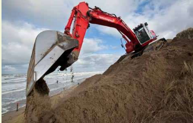
Januari 2013, halverwege Zandvoort en Noordwijk. Graafmachines maken de eerste kuilen in de besneeuwde zeereep van 'Noordvoort'. Als de dichte begroeiing is weggehaald en de machines naar huis zijn is de wind aan beurt om het zand laten stuiven waarheen hij maar wil. Foto: Joost Bouwmeester.
