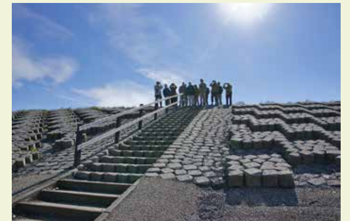
De Hondsbossche en Pettemer zeewering voor de nieuwe versterking. Foto: Gerrit van Ommering
