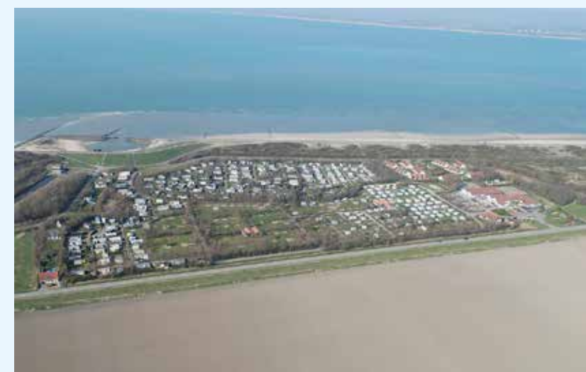
Waterdunen in aanleg. Foto: Adrie Provoost
